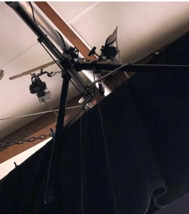
lisé avec un moteur de lève vitre de 12V avec une poulie. La tente est maintenue à la hauteur souhaitée par une corde. La corde et la tente sont maintenues par un fil de nylon fixé à la poulie. Quand le moteur tourne, le fil
