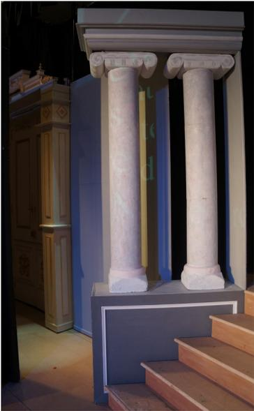
Les colonnes, les bases et les chapiteaux, récupérés du décor « Ne coupez pas mes arbres », sont montés sur un socle de 120x40 cm par 85 de haut et surmontés d'une corniche. Ces deux blocs de 3 mètres sont utilisés à l'acte I, cachées à l'acte II et réapparaissent à l'acte III avec un grand escalier comprenant la plateforme et l'escalier. (**blocs 5 & 6**).
